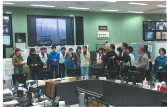
福島第一原発の中央制御室です。震災時はここで被害を拡大しないよう日夜対策が練られていました
